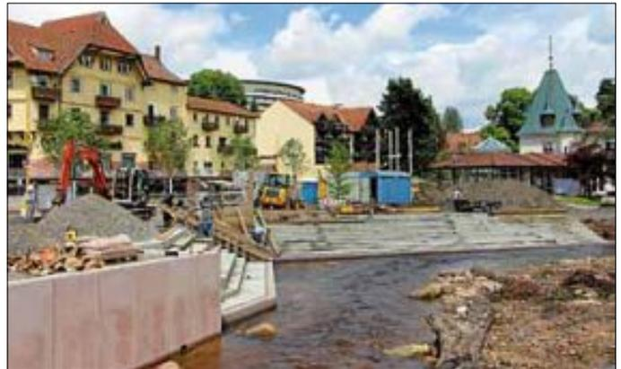
Am Kurparkeingang nahe dem Kreisverkehr am Rathaus entsteht derzeit ein neuer Aufenthaltsort direkt am Wasser – das weit gestaltete Mündungsbecken mit Sitzstufenanlage zum Flüsschen Alb. Das Fundament für die Treppenanlage ist weitestgehend fertiggestellt. Für die Oberfläche der Treppen werden ab dieser Woche rund 400 Betonfertigteile angeliefert.
