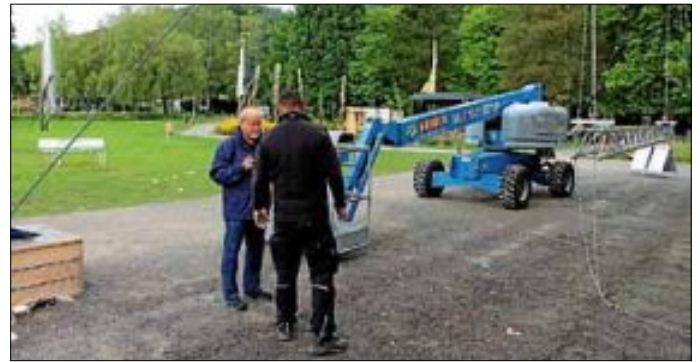
Der Rückbau des Veranstaltungszelts hat bereits begonnen
