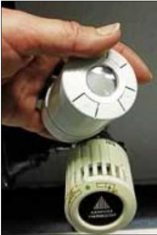
Aus alt mach neu: Wer ein regelbares Standard-Thermostatventil durch ein programmierbares Gerät austauscht, spart Heizenergie und Kosten und schafft Behaglichkeit. (Foto: © Energieagentur Rems-Murr)
