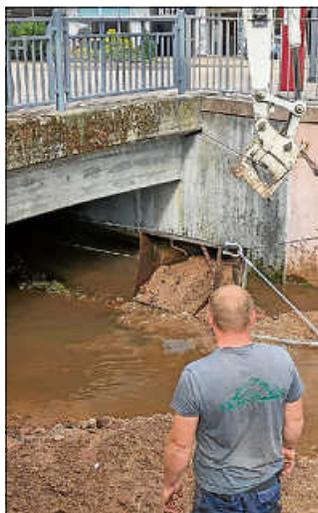
Mittels des Schürfkübels und einer Seilwinde wurden die Ablagerungen aus dem Flussbett unter dem Kreisverkehr entfernt.
