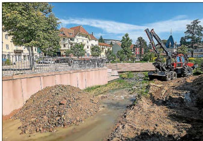
Die beidseitigen Ablagerungen im Mündungsbecken direkt nach dem Durchlass wurden entfernt. Damit hat die Alb an dieser Stelle wieder die Breite, die sie 2016 zur Fertigstellung des Mündungsbeckens hatte.
