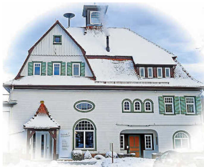
Stadtwerke Bad Herrenalb GmbH
