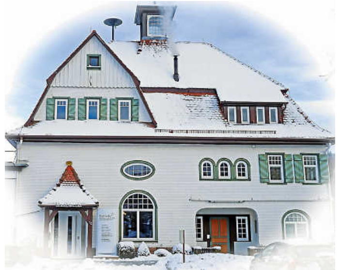
Stadtwerke Bad Herrenalb GmbH
