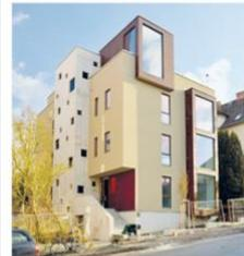
Nachverdichtung als Holzrahmenbau auf vier Ebenen, durchgängig in Holz.
